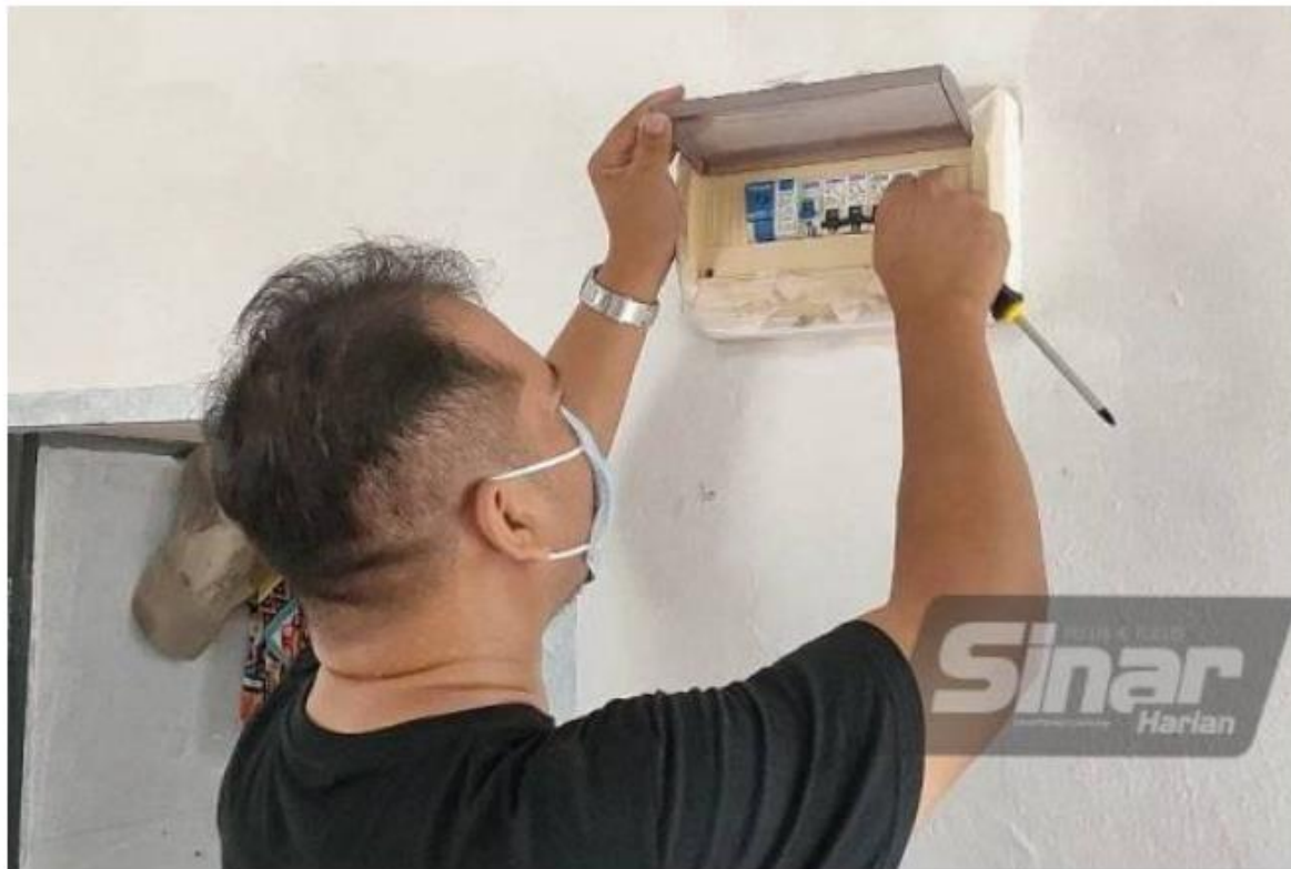
Mohd Zulafendi memeriksa pendawaian elektrik di rumah salah seorang mangsa banjir di PAKR Bukit Rangin pada Khamis.
